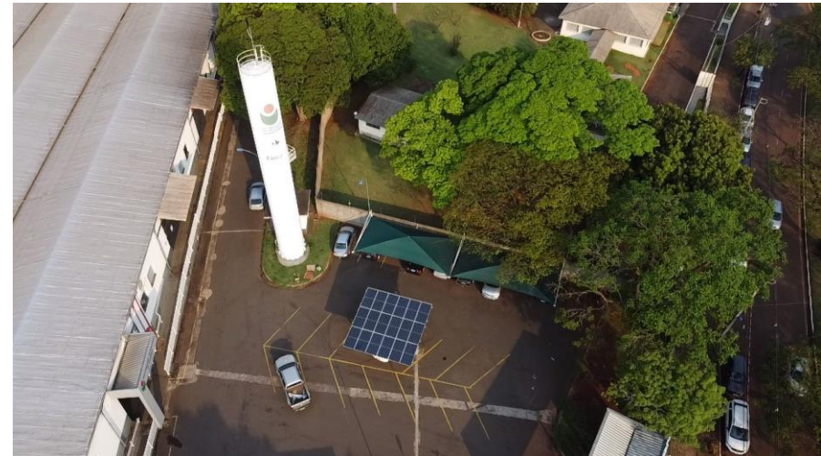
Heliuz Engenharia possui placas instaladas no pátio da incubadora.
